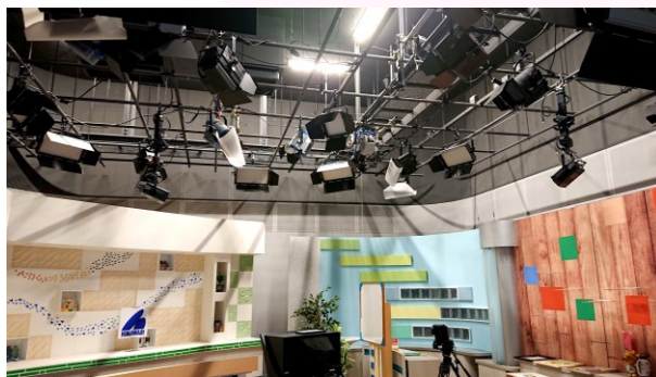
3階スタジオ照明LED化
